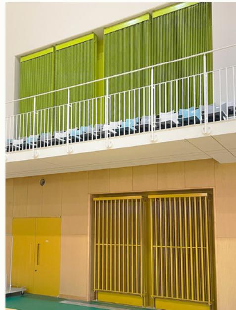
牧之原市多目的体育館(GasOneアリーナ牧之原)は2024年5月にオープンした新築の体育館です。館内の冷暖房設備としてアリーナと観客席に除湿型冷暖房PS HR-Cが採用されています。
