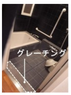
グレーチングを設けることでフラットな設計とした浴室出入口
