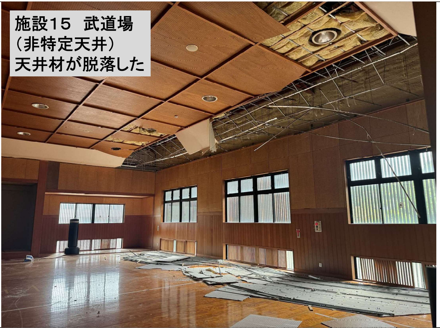
施設16 武道場 (非特定天井) 天井材が脱落した
