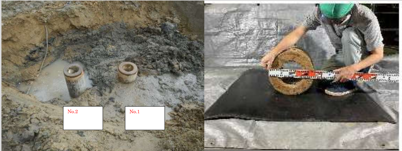
写真3.8 B建物の杭
