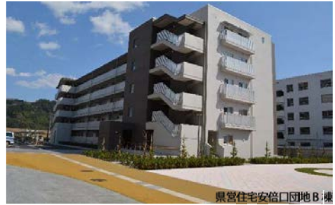
県営住宅安倍口団地B棟
