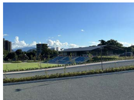
鮎壺公園交流施設
